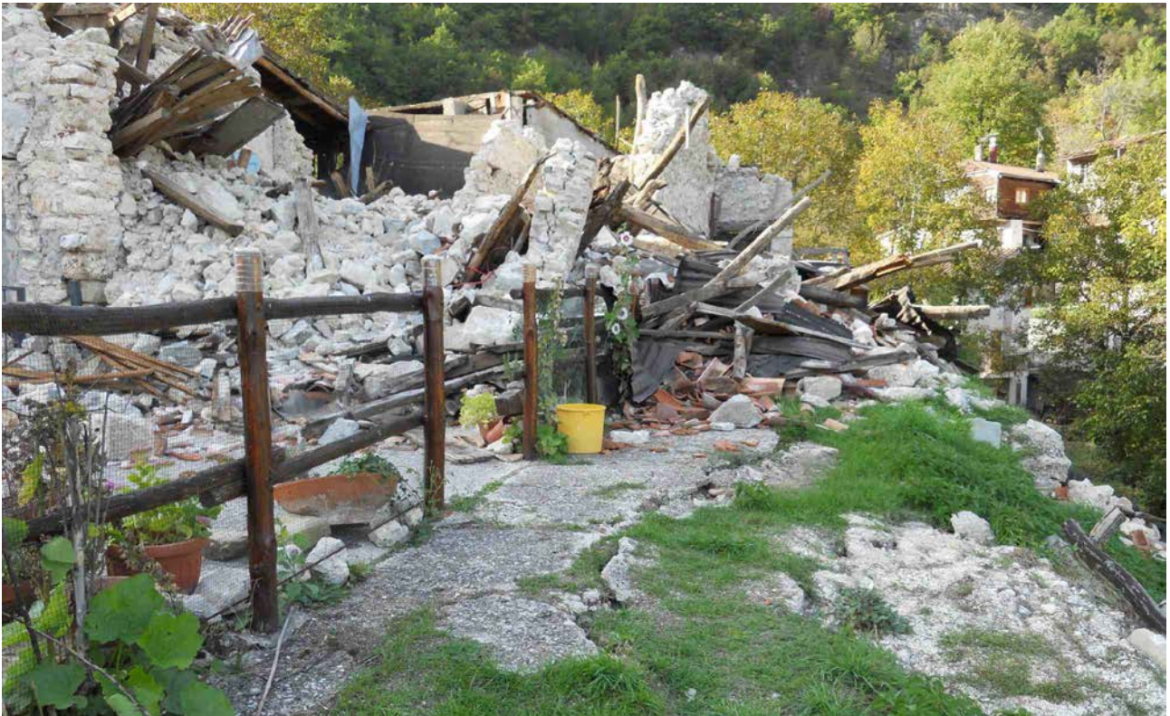
Danni prodotti dal terremoto del 29 dicembre 2020 in Croazia.
