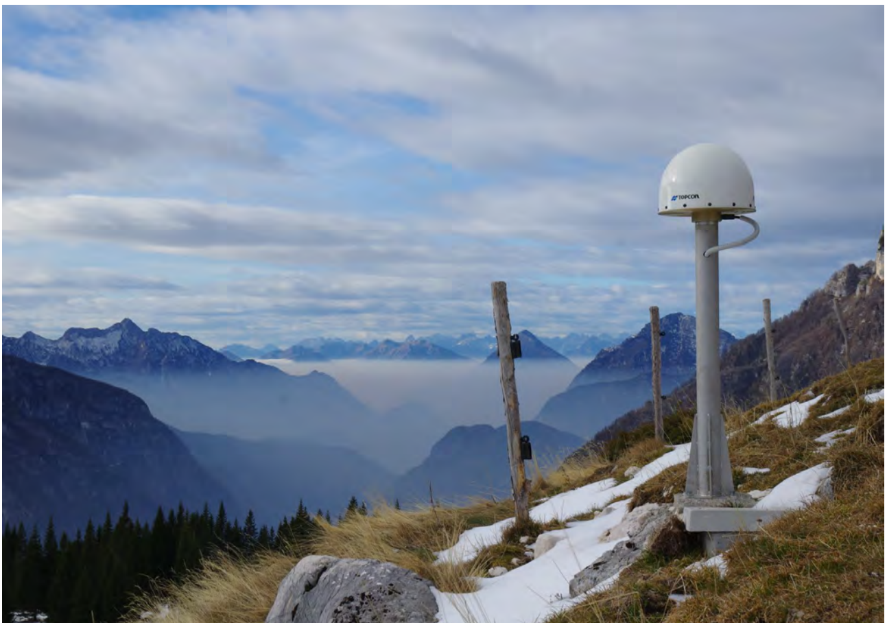
Stazione del sistema di monitoraggio terrestre dell'Italia Nord-Orientale (SMINO).
